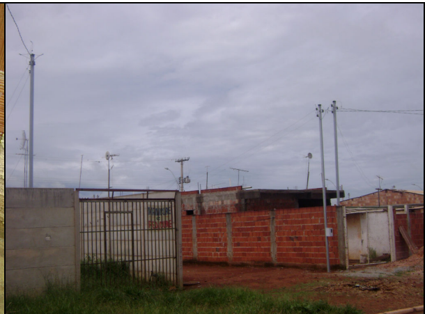
Foto 2 – Rede Elétrica – ligação domiciliar executada
