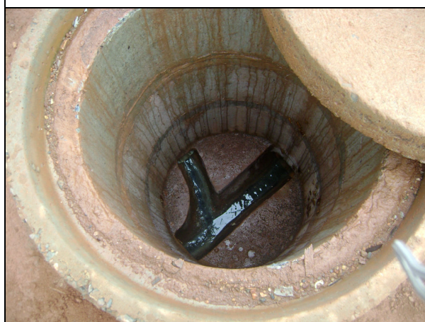
Foto 5 – Rede Coletora de Esgoto – Poço de Visita Executado
