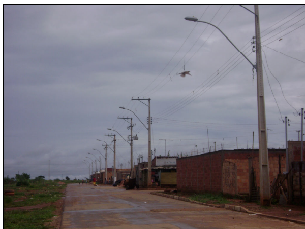
Foto 3 – Execução da Rede Elétrica na QNR 05
