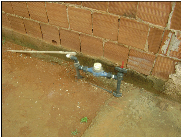
Foto 1 - Instalação de Hidrômetro em Rede de Distribuição de Água
