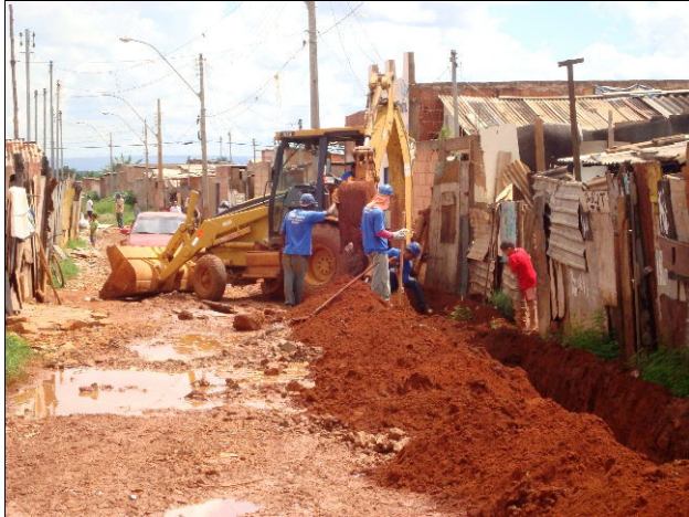
Escavação mec.- rede coletora
