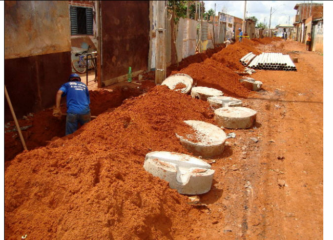
Escavação manual - rede coletora
