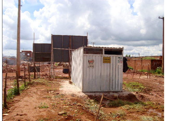
Barraco de obra - Estação Elevatória
