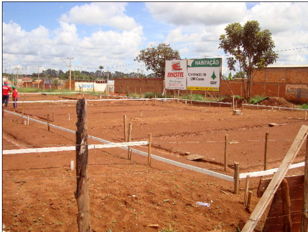
Construção das 1.290 casas - obras iniciadas
