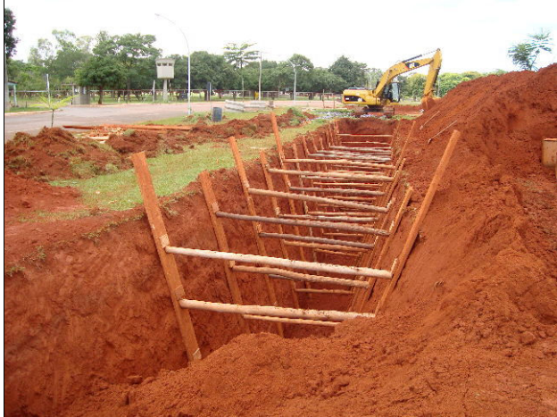
Escavação e escoramento
