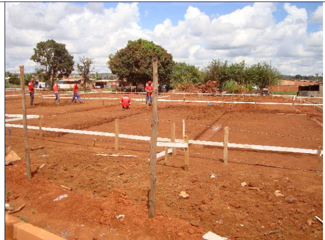
Construção das 1.290 casas - obras iniciadas
